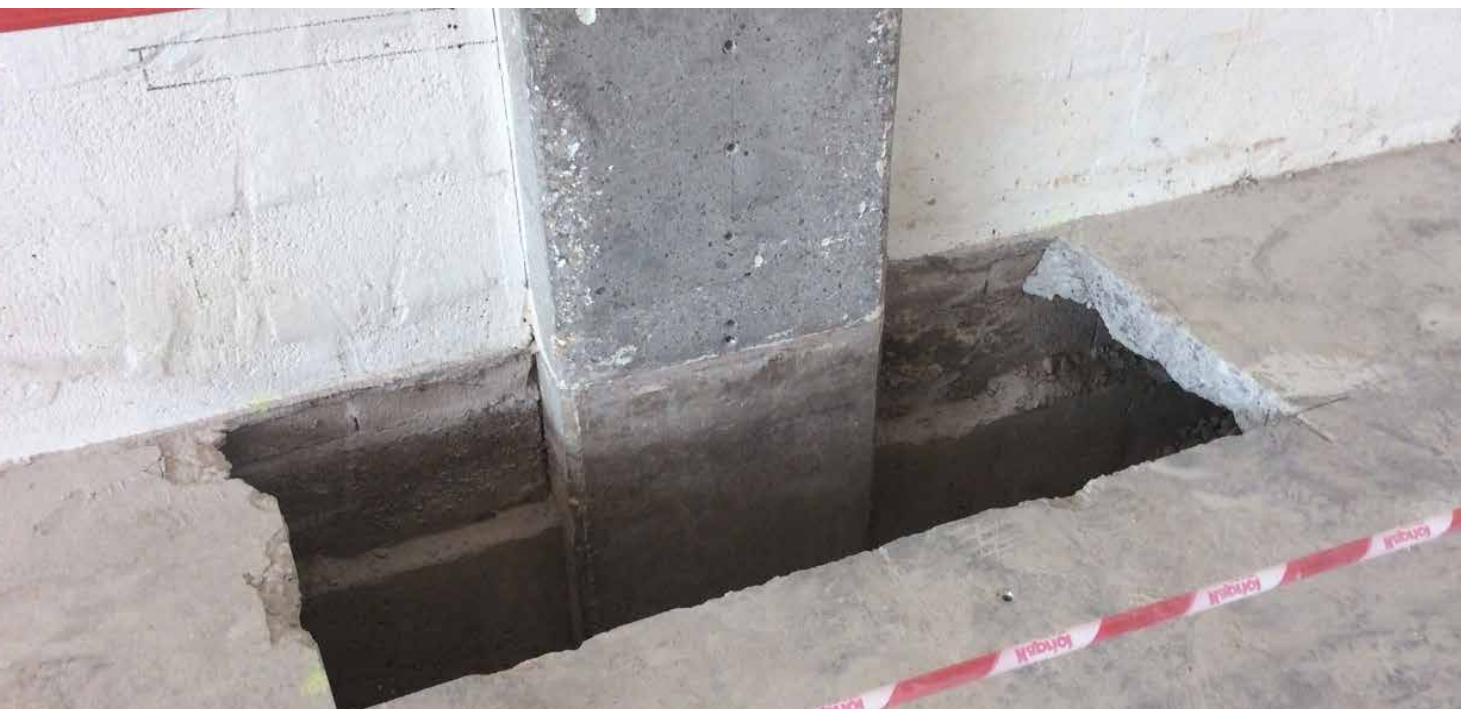
Sopra: demolizione del pavimento per l'inserimento delle barre verticali, sotto: un pilastro dopo il getto di GEOACTIVE FLUID B 530 C
