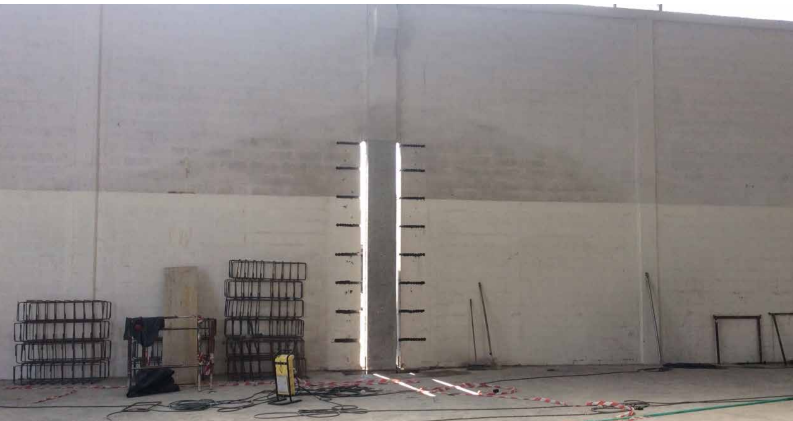
Preparazione delle murature per l'inserimento dei vincoli di innesto con barre di metallo
