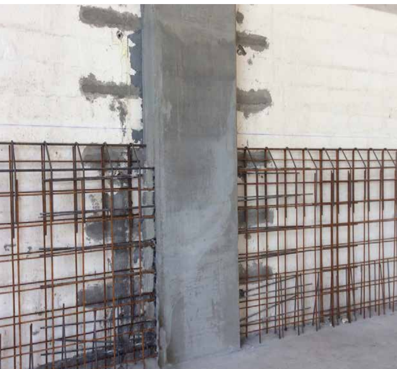
In alto: posizionamento delle nuove barre di armatura, in basso: i pilastri dopo il getto di GEOACTIVE FLUID B 530 C
