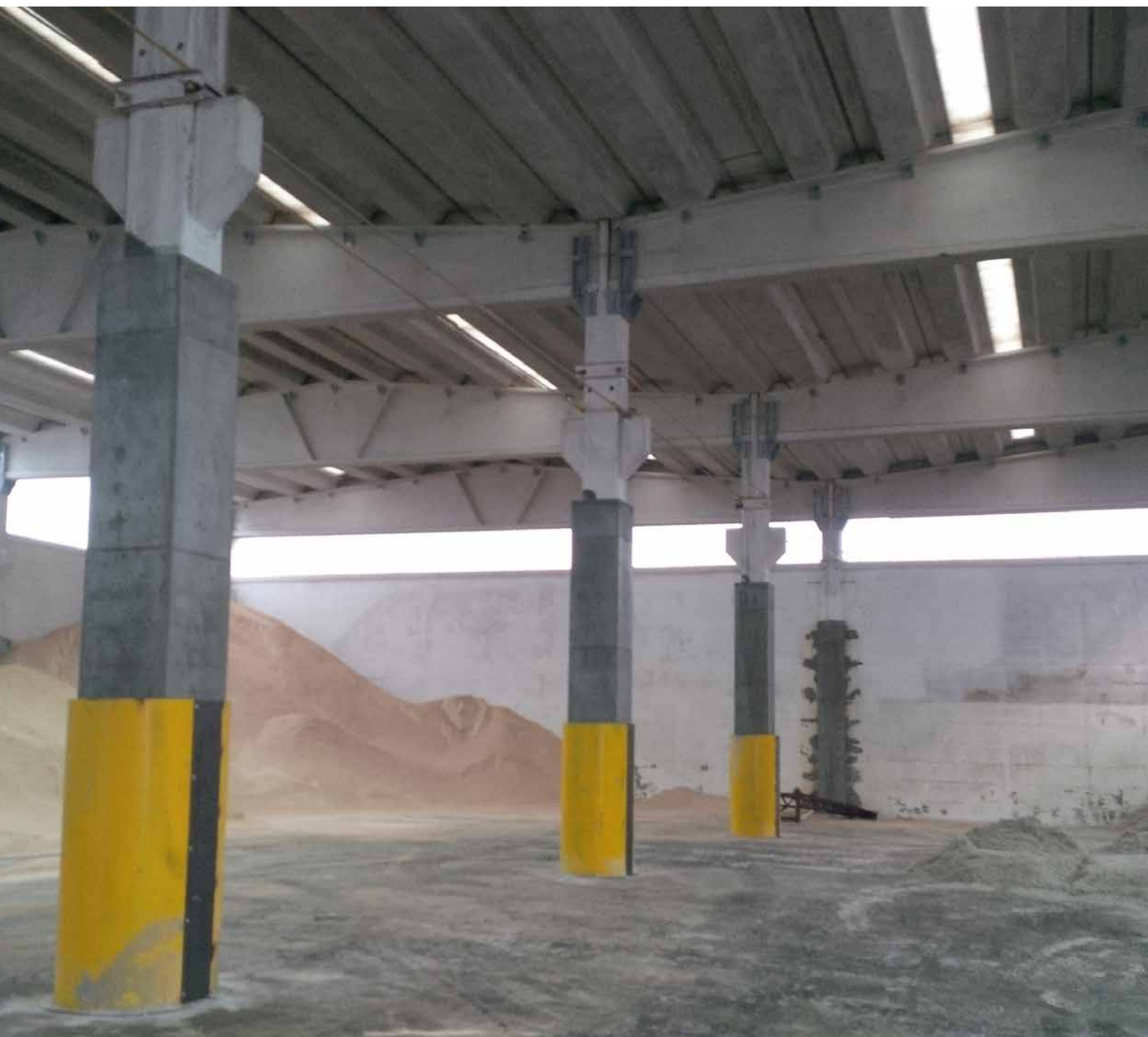
I pilastri dopo l'intervento
