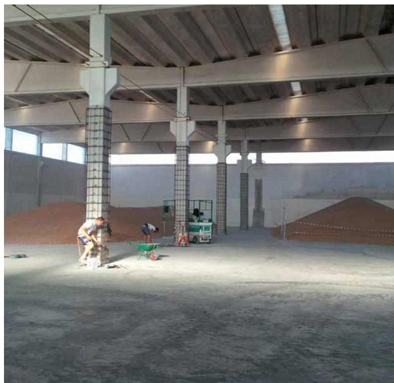
In alto: posizionamento delle nuove barre di armatura, in basso: i pilastri dopo il getto di GEOACTIVE FLUID B 530 C
