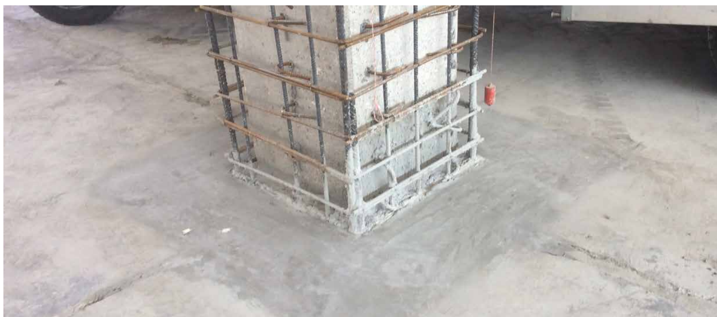
Sopra: demolizione del pavimento per l'inserimento delle barre verticali, sotto: un pilastro dopo il getto di GEOACTIVE FLUID B 530 C
