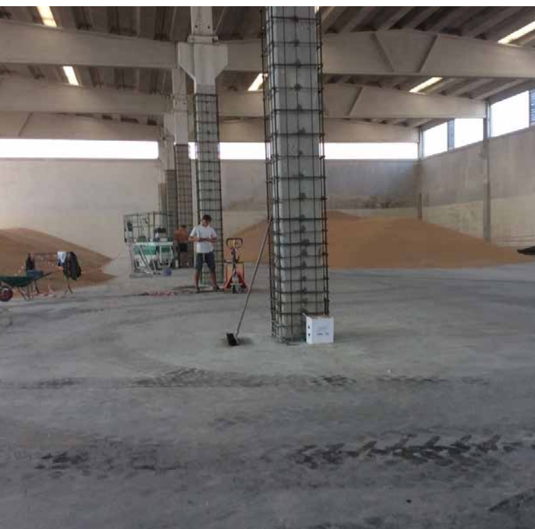
In alto: posizionamento delle nuove barre di armatura, in basso: i pilastri dopo il getto di GEOACTIVE FLUID B 530 C
