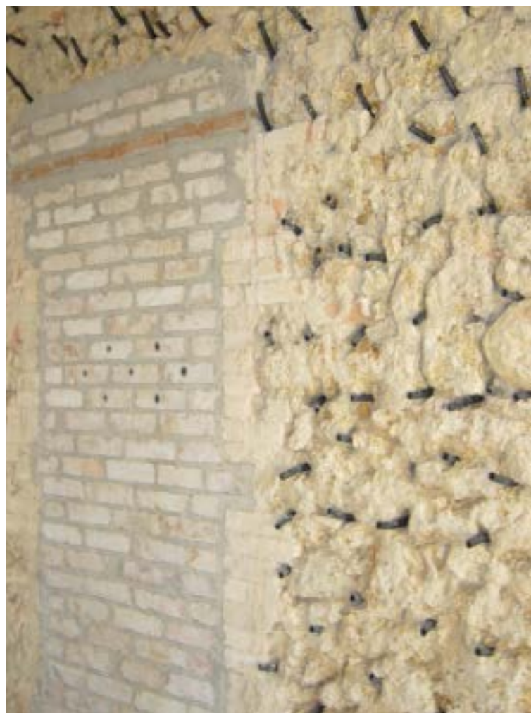
Tubazioni inserite nelle murature per iniettare il materiale di riempimento
