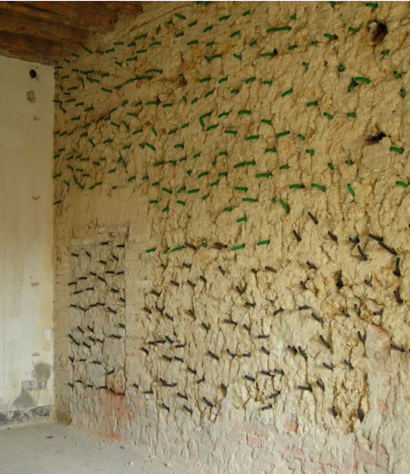
Muratura perforata e inserimento dei tubicini di riempimento
