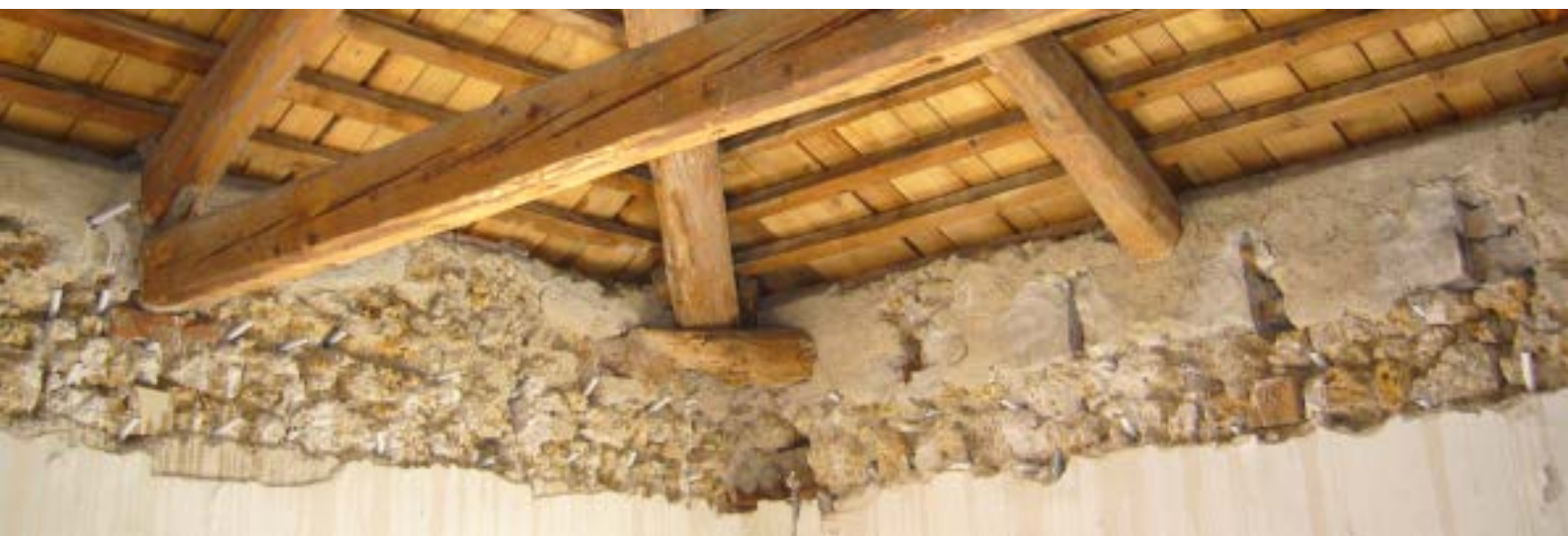
Preparazione dei tubicini nel sottotetto del primo piano
