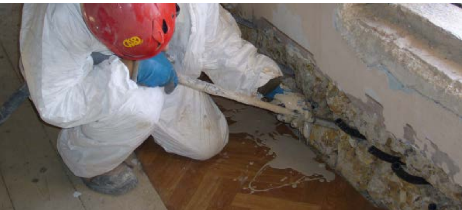
Preparazione dei tubicini nel sottotetto del primo piano
